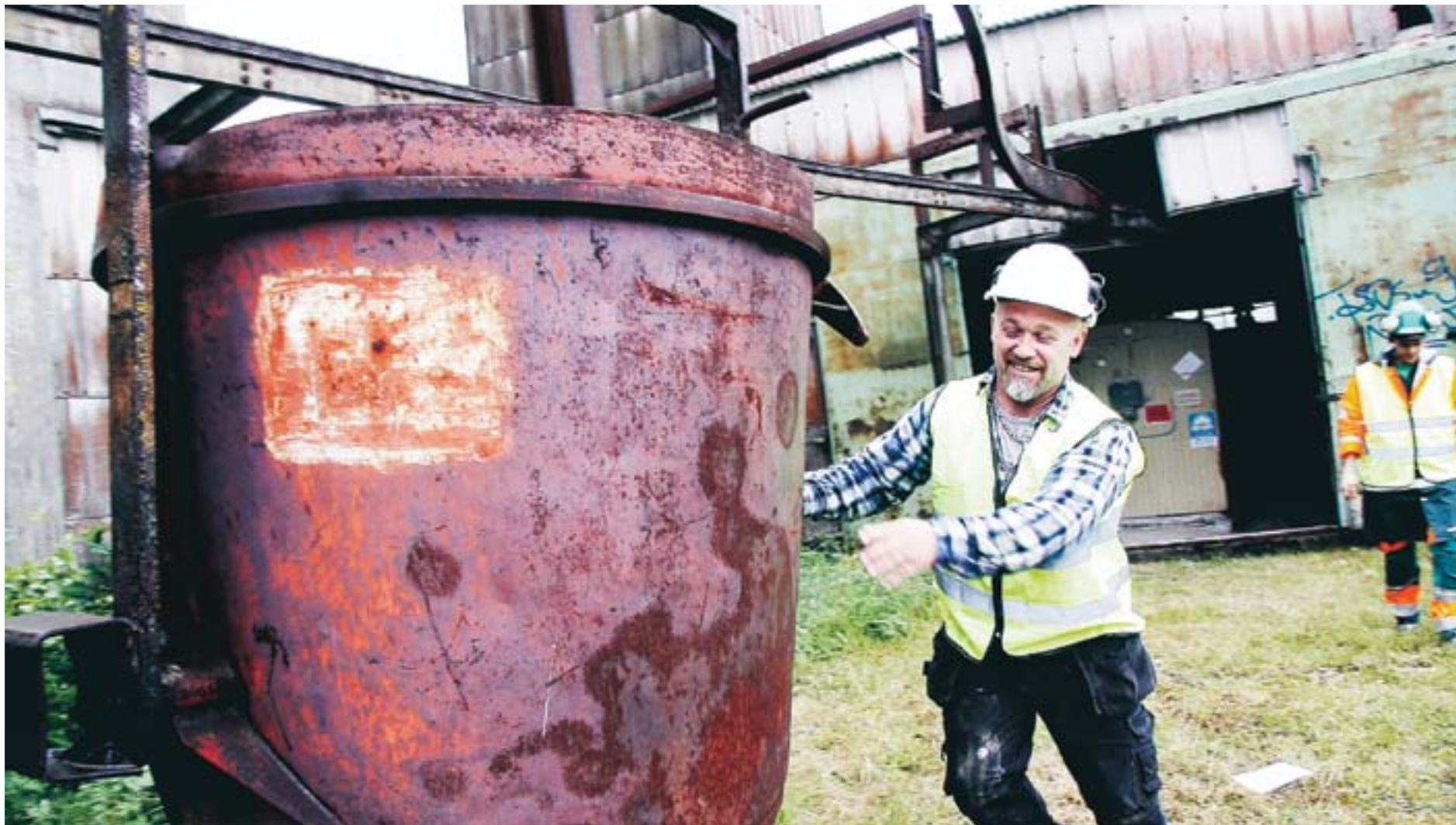
RIVNINGPÅBÖRJAD. I förrgår började nedmonteringen av kalklinbanan. Här är det Niklas Gunnarsson som tar ner en av hinkarna i Forsby.
